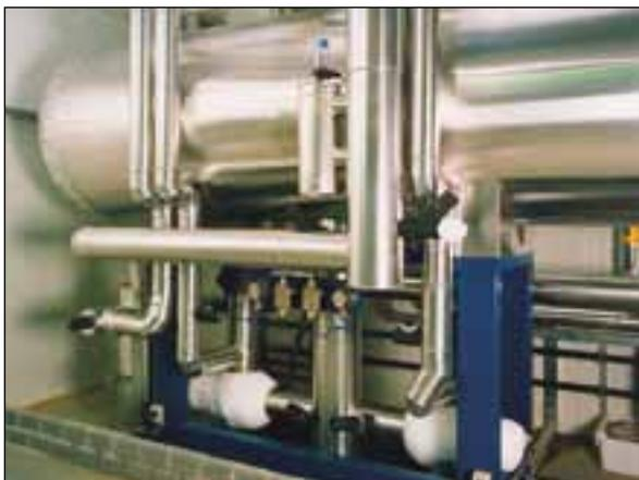
Ansicht einer CO<sub>2</sub>-Kälteanlage mit Pumpensystem
